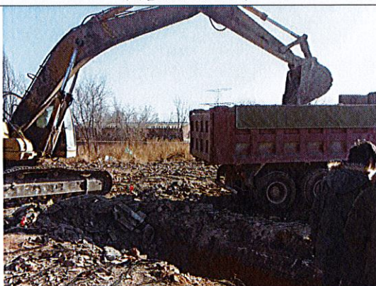
污染土壤开挖
